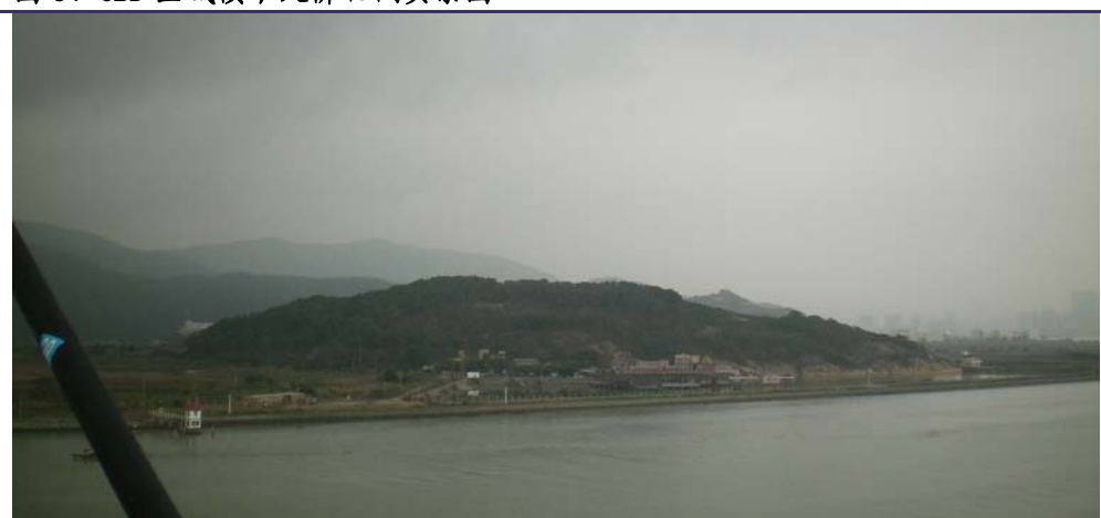
图 3、CBD 区域横琴大桥北侧实景图
