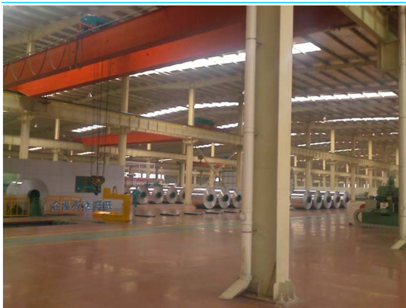
图 4：二期生产线现场
