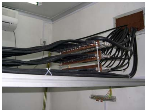
图 9 射频电缆机房内布线
