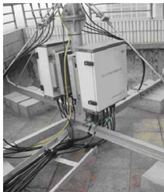
图 8 室外射频电缆
