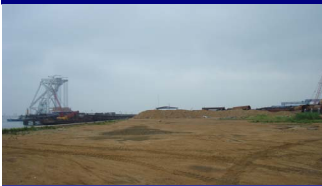
图 2：胜通海岸填海造地项目现场图一
